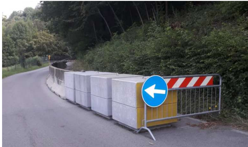
Primo ordine di difesa provvisoria con new jersey in cls ancorati alla pavimentazione stradale
